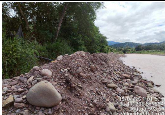
FOTO N°02: EN LA VISTA FOTOGRÁFICA SE OBSERVA LA COLMATACION CON MATERIAL PROPIO EXISTENTE EN LA MARGEN DERECHA DEL RIO YURINAKI A LA ALTURA DEL SECTOR PUERTO YURINAQUI
